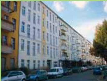
Wohnhäuser mit 180 Wohnungen in der Beermannstraße
